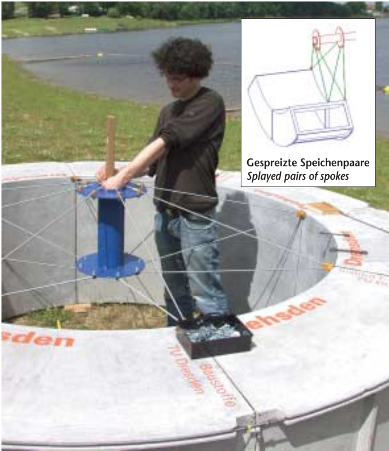
Einbau und Ausrichten der Nabe Mounting and adjustment of the hub Bild: TU Dresden
